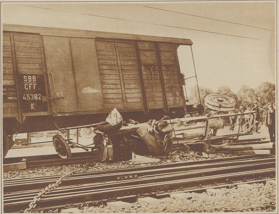
Das Auto unter dem Eisenbahnwagen. Auf der Station Ziegelbrücke fuhr am Samstag bei geöffneter Barriere ein Lastwagen in einen manövrierenden Güterzug hinein und wurde vollständig zertrümmert. Der Chauffeur und zwei mitfahrende Arbeiter entgingen durch rechtzeitiges Abspringen wohl dem sichern Tode
