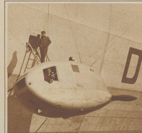
Eine der fünf Motorgondeln, in die man über eine Leiter aus dem Innern des Luftschiffes gelangt
