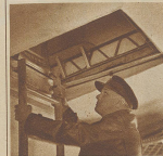
Aufstieg durch die Luke ins Innere des Luftschiffes
