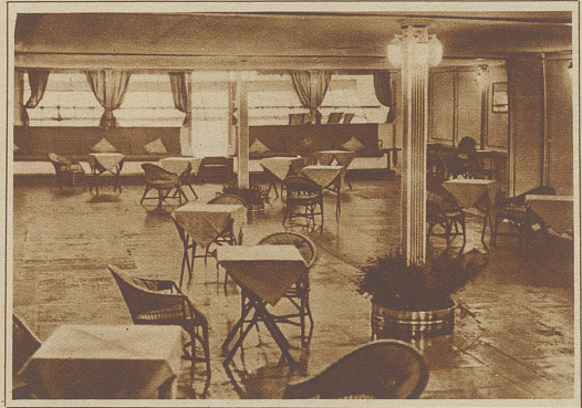
Der große Gesellschaftsraum des 100 Personen fassenden Luftschiffes
