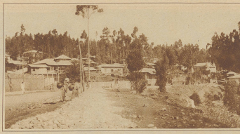
Partie an der Ras Makonnenstraße. Sie führt von der Stadt zum Hof des Kaisers Tafari, sowie zum Palais der Kaiserin. Zwischen, ferne zu den Chausseebahnen. Dabei die verhältnismäßig gute Zettelung.
