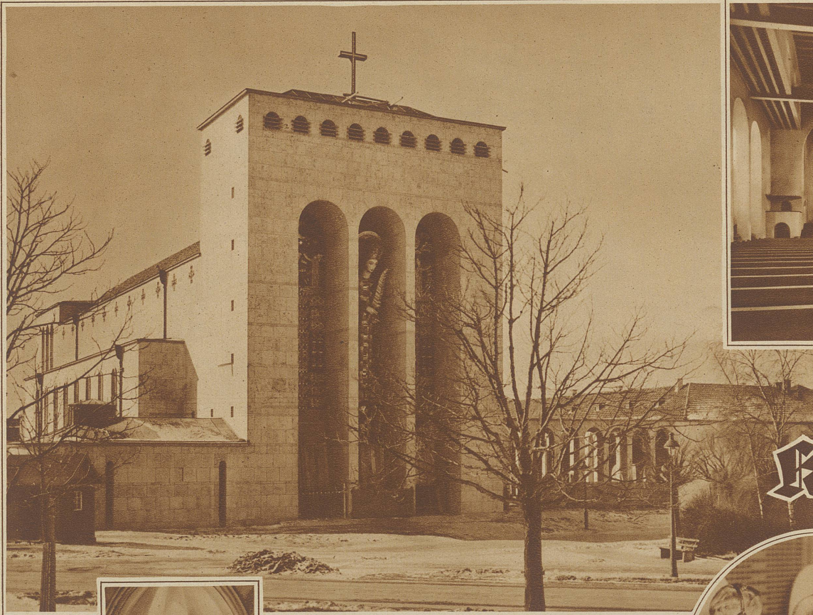
Die Frauenfriedenskirche in Frankfurt a. M., vollständig in Beton ausgeführt, ist ein Beispiel für das heutige Streben nach neuen Bauformen Phot. Dr. P. Wolff
