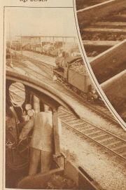
Das «Götter» des Rangierbahnhofs. Elektrische Weichenstellung im Stellwerk
