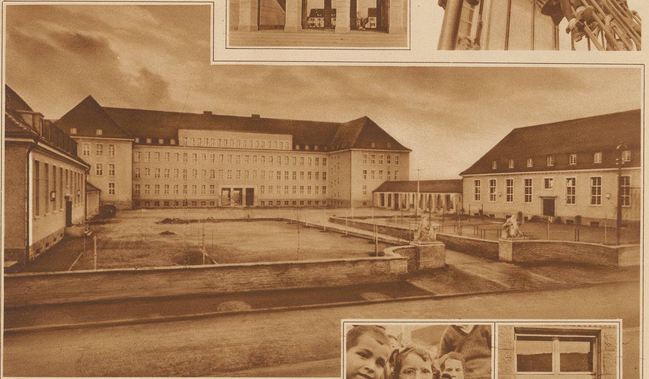
Gesamtansicht des neuen Schulhauses mit Turnhallen
