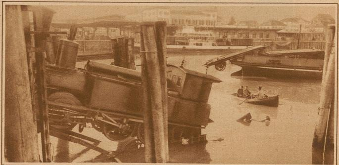
**Trajektunglück in Romanshorn.** Infolge des außerordentlich tiefen Wasserstandes erhielt die Brücke zum Trajekt Kahn eine so starke Neigung, daß die zur Entladung bestimmte Lokomotive ins Gleiten kam. Der Tender und zwei beladene Wagen stürzten in den See, während die Lokomotive teilweise noch auf der zusammengestürzten Brücke stehen blieb. Der Lokomotivführer, der Heizer und ein Matrose konnten sich durch einen Sprung ins Wasser retten, ersterer erlitt dabei einen Beinbruch (Phot. Kistinger)
