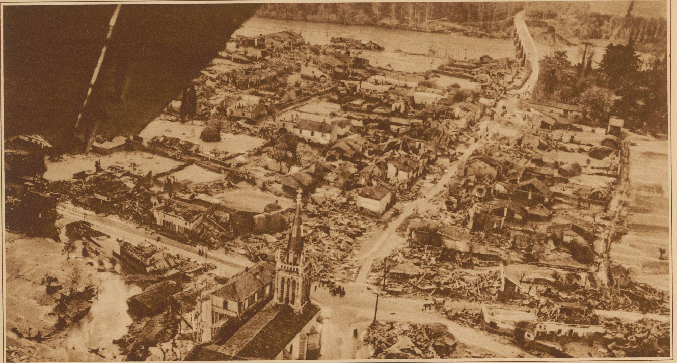
Flugzeugaufnahme eines durch die Ueberschwemmungskatastrophe in Südfrankreich zerstörten Dorfes
