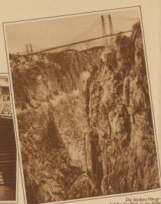
Die höchste Hängebrücke der Welt in der Nähe von Cañon City in Colorado (Vereinigte Staaten). Im Herbst 1931 ist sie 160 m von 300 m über die Grand-Gorge-Fels. Die Spannweite von Träger zu Träger beträgt 270 m, die ganze Länge der Brücke 380 m
