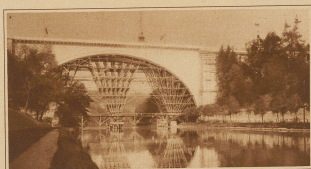
Die neue Lorrainebrücke in Bern. Das Hauptgewölbe im Bau am 15. November 1928. Dahinter die Eisenbahnbrücke
