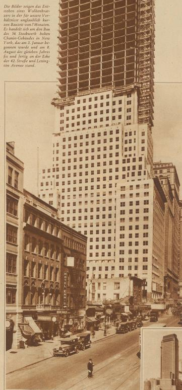
Die Bilder zeigen den Einbau eines Wolkenkratzers in der für unsere Verhältnisse unglaublich kurzen Bauzeit von 7 Monaten. Es handelt sich um den Bau des 36 Stockwerke hohen Chalmers-Gebäudes in New York. Das am 3. Januar begonnen wurde und am 8. August des gleichen Jahres fertig ist, liegt an der Ecke der 42. Straße und Lexington Avenue.
