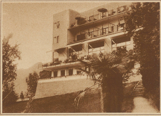
Das neue Kurhaus Monte Verità
