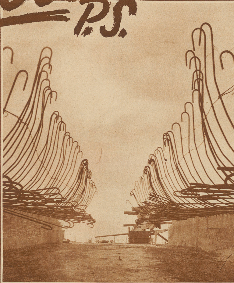
Eine moderne Allee. Eisenskelet für die Turbinenausläufe
