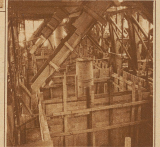
Verschaltungsarbeiten für die Wehrfelder des Stauwehres bei Markt
