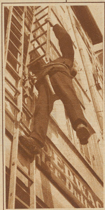
Bild rechts: Wahrlich keine leichte Sache, am Leibgurt angehängt und auf halber Schuhsohle stehend die Leiter hochzuheben, glatt an der Hauswand!
