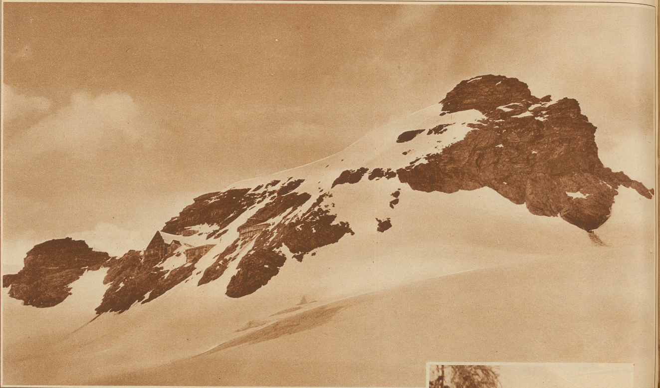
An den Felswänden der Sphinx erkennt man links das Berghaus Jungfrauoch und rechts daneben die im Bau begriffene Forschungsstation
