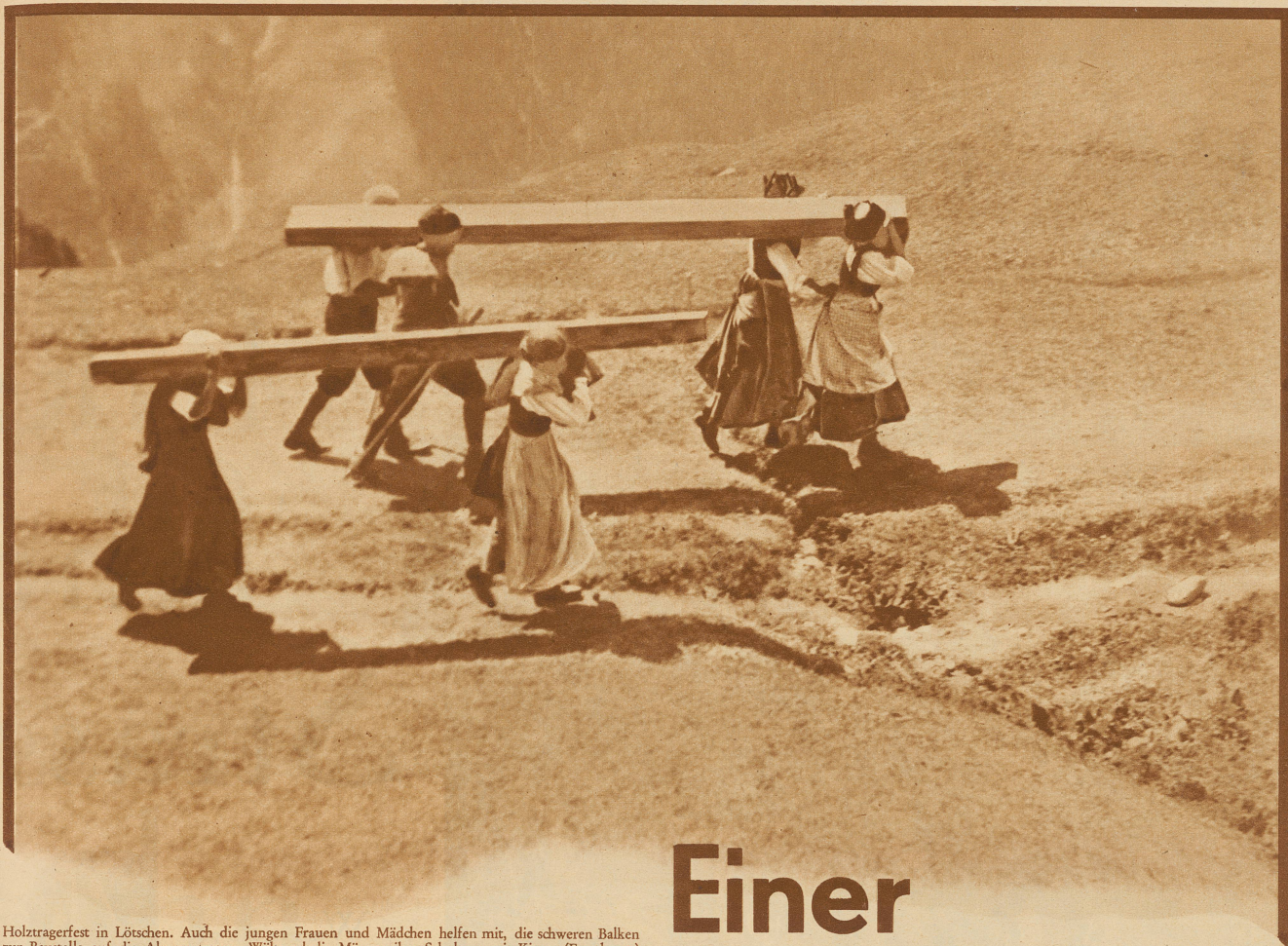
Holztragerfest in Lötschen. Auch die jungen Frauen und Mädchen helfen mit, die schweren Balken zur Baustelle auf die Alp zu tragen. Während die Männer ihre Schultern mit Kissen (Epauletten) schützen, tragen die Frauen die kantige Last nicht selten ohne den geringsten Schutz
