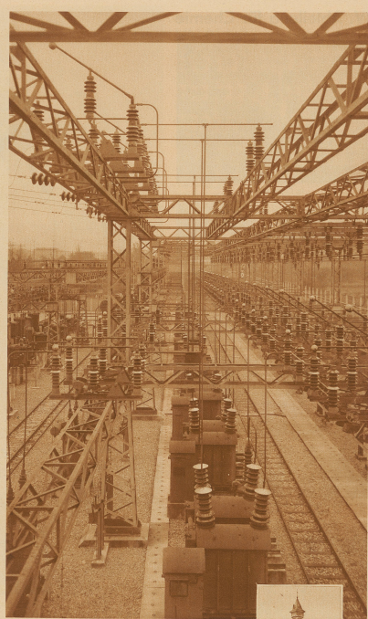
S.B.R. Unterwerk Sebach. Hier wird der Strom von 60000 Volt auf 15000 Volt herabtransformiert; erst in dieser Spannung ist er für die Filtration zu gebrauchen (Foto: S.B.R.)
