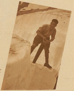
Aussagen von Firnschnee. Die Blöcke wurden bei der oberen Schlittenseilbahn über den Gletscher zur Be- lastung der talwärts fahren- den Schlitten verwendet
