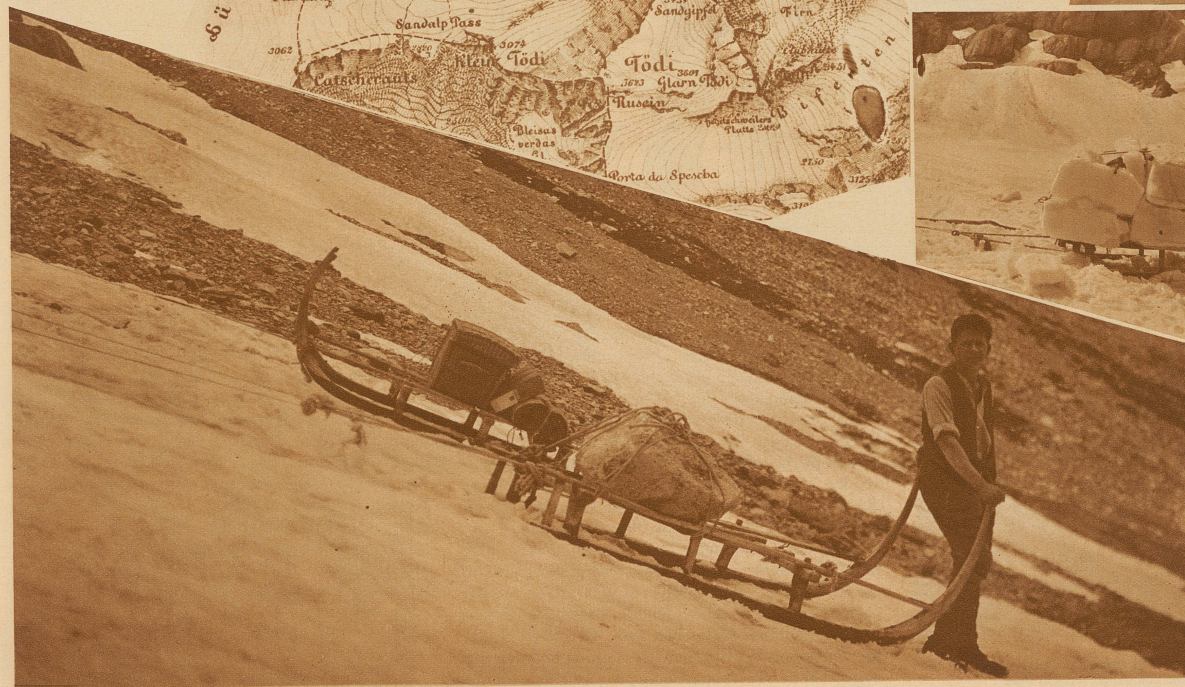
Aussagen von Firnschnee. Die Blöcke wurden bei der oberen Schlittenseilbahn über den Gletscher zur Be- lastung der talwärts fahren- den Schlitten verwendet
