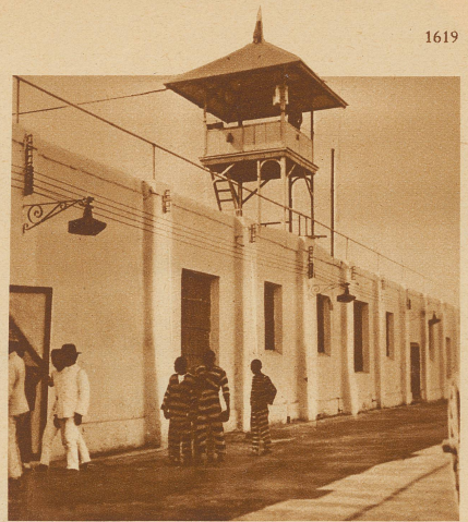
Wachturm auf der elektrisch gesicherten Gefängnismauer
