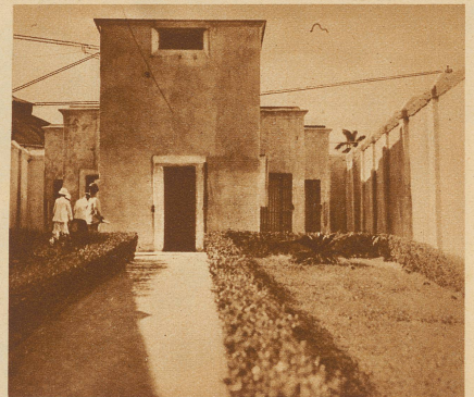
Das Haus des Todes, in dem der elektrische Stuhl steht
