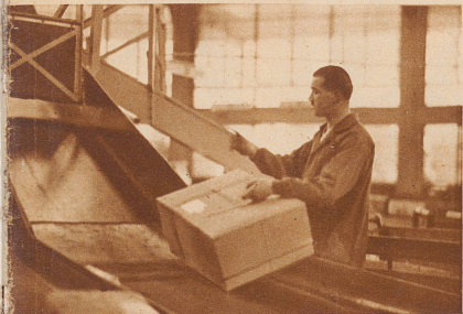
F. Erst hier am Fuß der Rutsche wird das Paket wieder in die Hände genommen, um nach nochmaliger Sortierung in den richtigen Wagen gebracht zu werden
