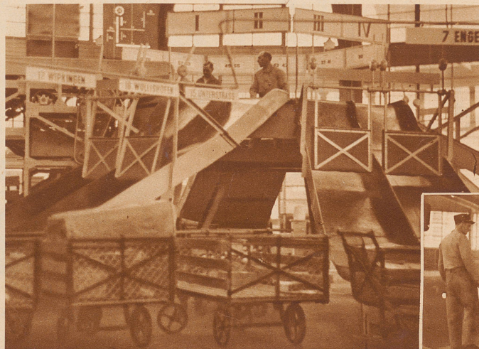
F. Die Sortieranlage der Paketausgabe
