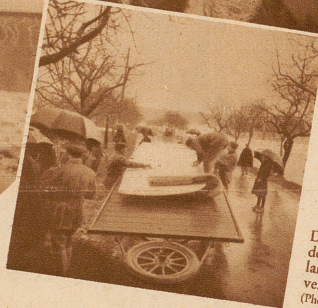
Das DH. 5-Flugzeug mußte bei Herzogenbuchsee notlanden. Zum Abtransport mußten die Tragflächen demontiert werden (Phot. Link, Basel)
