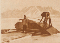
Propellerschleppen auf dem zugefrorenen Igroerifjord, bereit, ins Innere abtransportiert zu werden.
