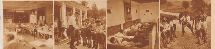
Die neue Schulstube auf dem «Hoggen»
