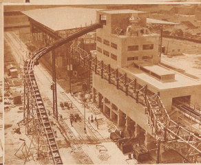
Am die Koksabreitunganlage mit ihrem Wärmegewinn. Transporter und Förderer schließt sich die Kokslegeteile, 16 m hoch, 1,7 m lang, 4 m breit, mit Raum für 6000 Tonnen Koks.
