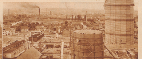
Neben dem mächtigen Gasbehälter von 50000 Kubikmeter Inhalt sieht man ein Wasserbehälter mit 10000 Kubikmeter Inhalt, während jenseits die über die beiden Gasometer der alten Gasfabrik, die 35000 und 50000 Kubikmeter fassen, weiterhin stehen Dornen aus.
