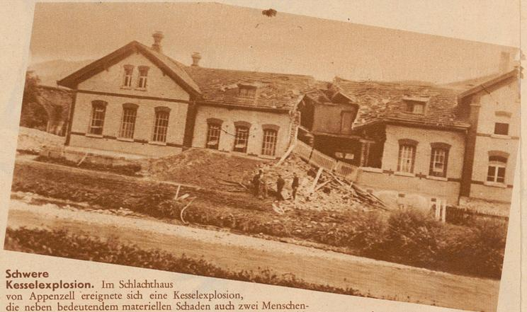
**Schwere Kesselexplosion.** Im Schlachthaus von Appenzell ereignete sich eine Kesselexplosion, die neben bedeutendem materiellem Schaden auch zwei Menschenopfer forderte. Der viele Doppelzentner schwere Kessel durchschlug Mauern und Dach des Gebäudes und wurde 130 Meter vom ursprünglichen Standort entfernt in die Sitter geschleudert
