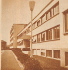
Fassadenansicht der neuen Bibliothek an der Bernstrasse
