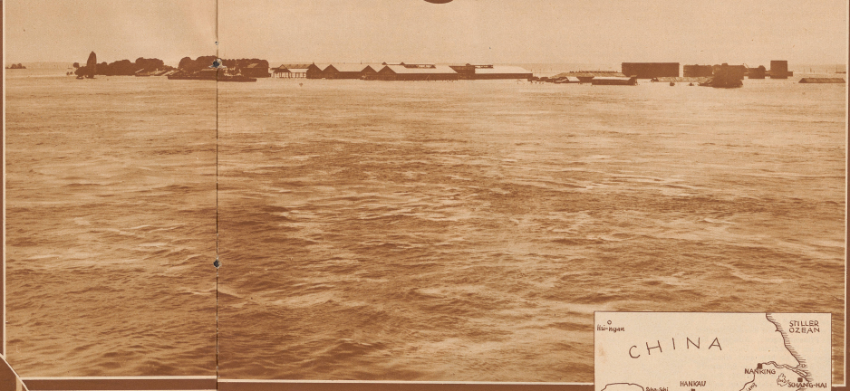
Die Handelsniederlassungen um Hankau waren durch Dämme gegen das Wasser geschützt. Der Strom hat die Dämme weggeführt, und die Lagerhäuser, Siles und Oelkants stehen jetzt in einem mehrere Meter tiefen See
