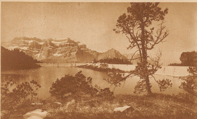
Der Stausee des Kraftwerkes Sernf-Niederengbach. Der See liegt 1620 Meter über Meer im Talkessel auf Garichte im Kärpfergebiet und fasst rund 3 Millionen Kubikmeter. Er mußte mit zwei Mauern von 230 m Länge und 36 m Breite bzw. 225 m Länge und 15 m Breite mit zusammen 59 000 Kubikmeter Beton errichtet werden.
