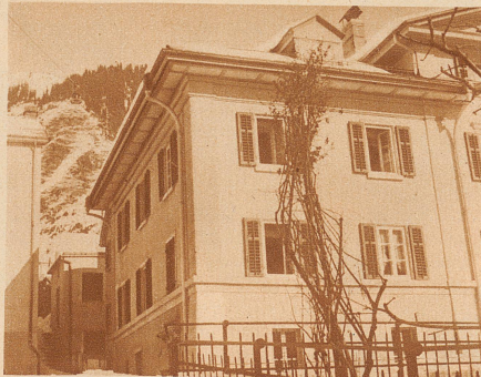
An der Stelle, wo jetzt dieses Gebäude der Militärverwaltung in Airolo steht, stand ehemals das Geburtshaus von Bundespräsident Motta. Im Dezember 1923 ist es von einer niedergehenden Lawine derart beschädigt worden, daß es abgebrochen werden mußte Aufnahme Keller
