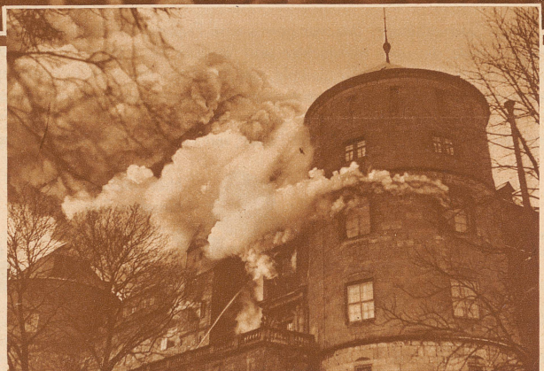
Eine halbe Stunde nach Ausbruch des Brandes im dritten Stock des Schlosses: Gewaltige Rauchwolken entsteigen dem Dachstuhl und ziehen über die Stadt
