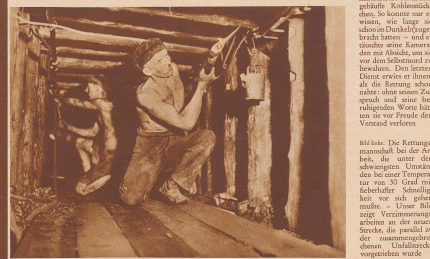
Die Rettungsmannschaft bei der Arbeit, die unter den schwersten Umständen bei einer Temperatur von 30 Grad mit feuchter Schweißluft vor sich gehen mußte. Unser Bild zeigt Verarmungswagen, die parallel zu der zusammengebrochenen Unfallstrecke vorgebracht wurde.
