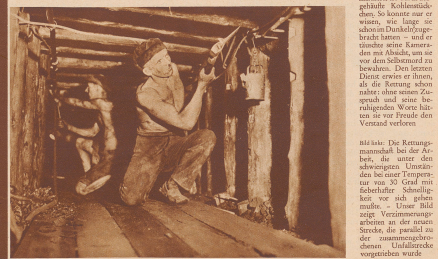
Die Rettungsmannschaft bei der Arbeit, die unter den schwervergessenen Umständen bei einer Temperatur von 30 Grad mit feuchter Schweißhaut, wie sich geben mußte. Unser Bild zeigt Verarmungsgewichte an der neuen Strecke, die parallel zu der zusammengebrochenen Unfallstrecke vorgestrichen wurde.
