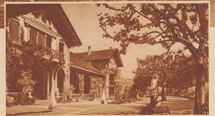
Ein Teil des Gebäudekomplexes (das Bäderhaus) vor dem Brand Aufnahme Kitting
