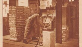
Das aus den Schmelzöfen kommende flüssige Metall wird in kleinen Gefäßen zu Büren gegossen, die man Masche nennt. Die erkalteten Masche kommt hernach in einen Gießmaschinen, wo die Bild zeigt, aus diesem Öfen erst wird das Metall in genügender Einheitsgröße gewonnen.
