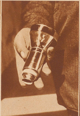
Eine Berliner Firma bringt einen neuen Rescue-Apparat für Ertrinkende den Handel, der großes Aufsehen erregte und vielleicht geeignet ist, das ganze Rettungswesen zu revolutionieren. Es ist ein kleiner flaschenartiger Apparat, der innen mit Carbide gefüllt ist. Im Falle von Gefahr wird er einfach in der Nähe des Ertrinkenden ins Wasser geworfen, versinkt zunächst, taucht dann aber wieder auf, da das Carbide im Wasser Gase entwickelt, die ihn an die Oberfläche treiben. Eine Ballonhülle, die am Kopf des Apparates angebracht ist, wird durch das eindringende Gas aufgebläht und hat eine derartige Auftriebskraft, daß sich drei Personen an dem Apparat festhalten können. — Links: der sogenannte Kiekbusch-Apparat vor dem Hereinwerfen ins Wasser, rechts der aufgeblähte Ballon, an dem sich der Ertrinkende festhält.
