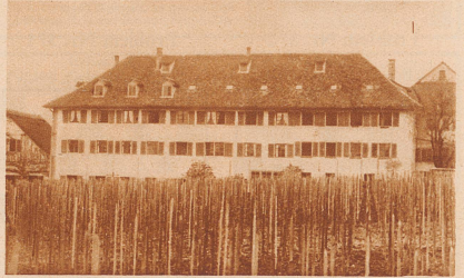
Das kantonale Lehrerseminar in Küsnacht, wo heute die Lehrerschaft der zürcherischen Volksschule herangebildet wird. Das Gebäude, eine ehemalige Johanniterkomturei, beherbergt das Seminar seit dem Frühjahr 1834
