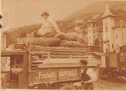
Das ganze Weekend-Haus reiste, auf einem Lastwagen verladen, von der Bahn an den Fuß des Berges ...
