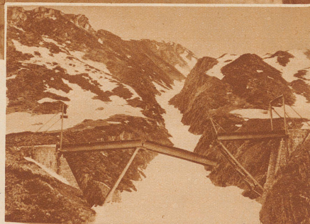
Daß in einem solchen Lawinenzug eine zusammenschiebbare und zusammenlegbare Brücke das einzig Zweckmäßige ist, veranschaulicht dieses Bild
