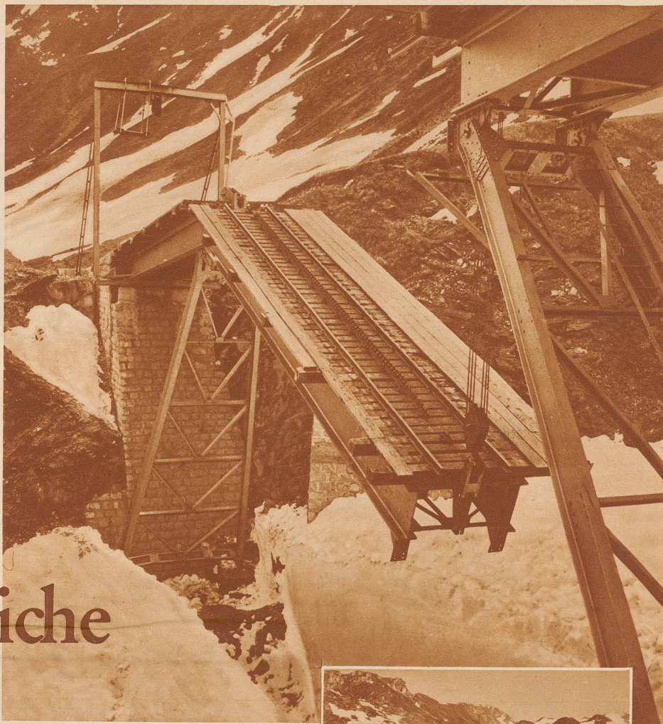
Wie die alljährliche Montage der Steffenbachbrücke vor sich geht: Der östliche Seitenteil mit dem niederhängenden Mittelstück, auf dem man das Geleise und die Zahnradspur erkennt, wird über den Brückenkopf vorgeschoben Aufnahme Feuerstein
