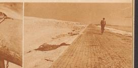
An der Krone mißt der Damm 90 Meier in der Breite. Auf dem Damm wird eine Ausstraße, ein Weg für Fußgänger und ein Fahrweg für den Spitzer soll hoch über die Doppelgänger Eisenbahn über den Damm gebaut werden. Eine Fähr über den Damm verbindet zwei phantasievolle Brücken. Der gedruckte Sand wird in der Sonne weiß wie Schnee.
