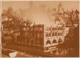
Großfeuer in Luzern. Vergangenen Sonntag fiel das Luzerner Gewerkschafts-Großhaus zum Opfer. Das Gebäude ist vollständig ausgebrannt. Der Schaden ist beträchtlich. Aufnahme obererem
