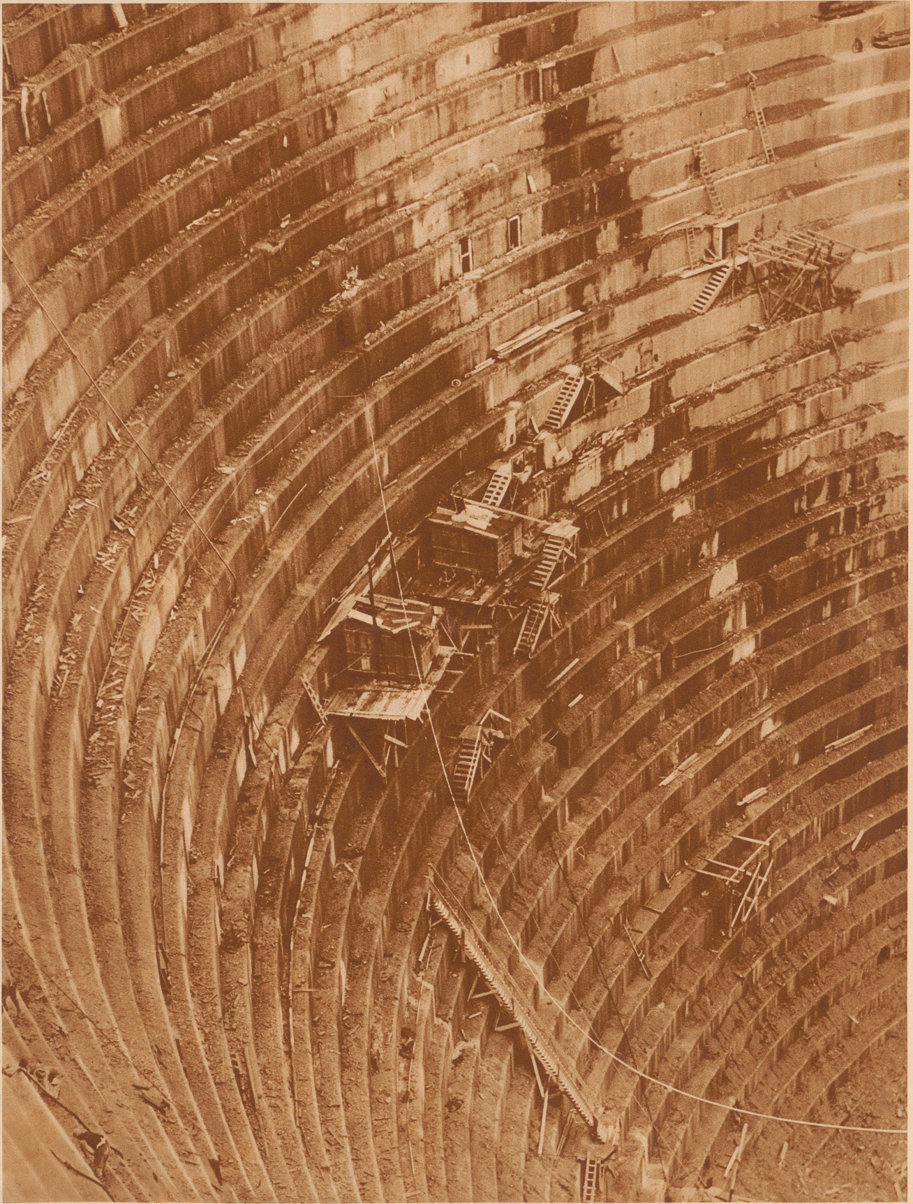
Das ist ein Ausschnitt aus der großen Spitalamm-Sperrmauer des Grimselwerkes, zur Zeit, da die Mauer fertiggestellt war und vom Bauschutt gereinigt wurde. Die Mauer ist 114 Meter hoch, an der Basis 65, an der Krone 4 Meter breit. Die zahlreichen Abstufungen sind gemacht, damit eine eventuelle spätere Steinverkleidung möglich wird. Die Absätze sind 2 Meter hoch und 1 Meter breit. Die kleinen Hütten, die wie Schwalbennester an der Wand kleben, sind Baubaracken. Sie vermitteln einen guten Maßstab der Riesenausmaße des Bauwerkes. Die sichtbaren Öffnungen in der Mauer werden zum Teil zum Messen der Mauertemperatur benützt, zum Teil sind es Fugen, die zur Konstruktion nötig waren
