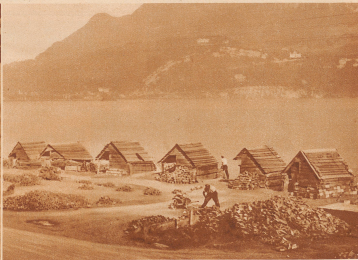
Die Werkhüfen am See. Direkt vor den Häuten die Stapelplätze der Steinhaufen, auf welchen die Tagesproduktion aufgeschichtet wird; dahinter die Sammelplätze der vom Unternehmer bereits abgenommenen Tagesproduktionen
