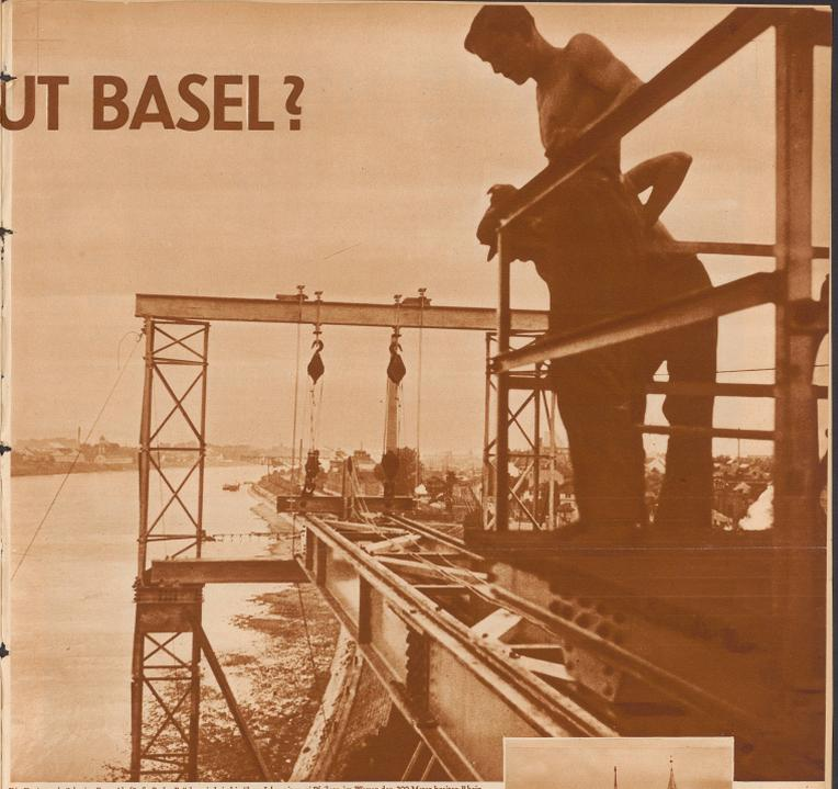
Die Dreierbrücke im Bau. Als fünfte Basler Brücke wird sie bis über Jahr mit zwei Pfeilern im Wasser den 200 Meter breiten Rhein überbrücken und Groß- und Kleinbasel noch tiefer als bisher miteinander verbinden.
