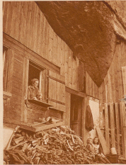
Flussmündung der Höhlenbewohner H. In die untere Partie des Felsens ist eine regelrechte Zweizimmerwohnung schön eingestrichelt. Durch die Haustüre gelangt man direkt in die Küche. Der darüber befindliche Teil der Verchaltung dient als Kamm. Beim Einbau der Wohnung wurde darauf Bedacht genommen, die Felsen in ihrem natürlichen Zustand zu lassen und die Verchaltung genau der Felsform anzupassen.
