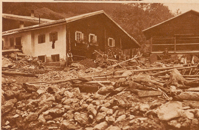
14. Juli 1932: So sah das Dörfchen Safien-Platz drei Tage nach der Katastrophe aus, als die ersten Freiwilligen vom Zivildienst eintrafen. Geröll, Schutt und Holztrümmer bedeckten meterhoch Straßen und Plätze. «Es war das reinste Chaos» — schrieben die Zeitungen
