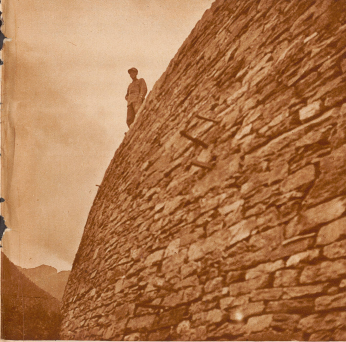
Solche Trockenmauern stehen unterwegs die. Stützbögen und Brücken. Fox und schin. Bese Arbeit. Alles vom italienischen Unternehmer gebaut für einen Betrag, der den Schweizer Straßenbauern nur ein bedauerndes Achselzucken einbrachte. So sehr man die Vierkilometer-Straßenstück da, zwischen dem armen Dörflchen Spruga und dem vergessenen naheliegenden Tälerthal im obersten Onsernonen. Jenseits der Grenze kreucht die neue Straße unvermittelt ab. — Schuldlos Italiener. Erst bei uns zu bauen, ehe sie an sich selber denken!
