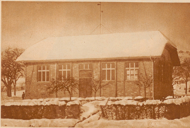
Die Turnhalle in Hallau
