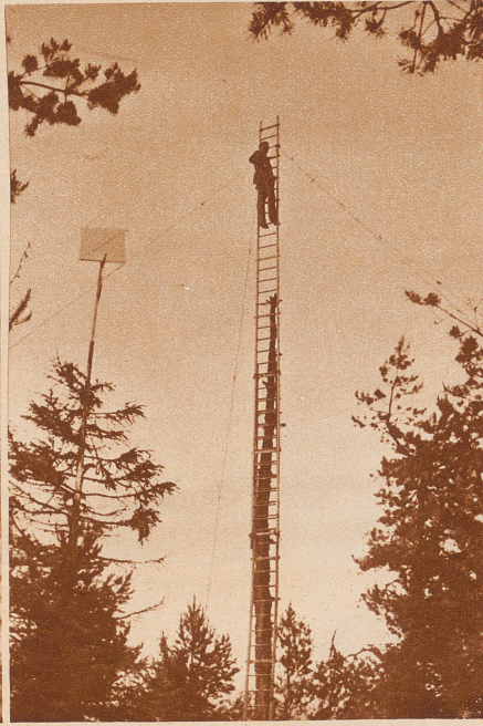
Der eigentlichen topographischen Aufnahme voraus geht eine gründliche Rekognosizierung des aufzunehmenden Geländes, die ihrerseits wiederum vielfach bedeutende Vorbereitungsarbeiten verlangt. So mußte zum Beispiel im Waldgebiet des Randen im Kanton Schaffhausen hoch über den Baumgipfeln ein Beobachtungsstand errichtet werden
