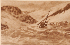
Die zerstörte Telefonleitung. Diese Leitung, die eine Spannweite von über 1000 Meter aufweist und im tiefsten Punkte 180 Meter über dem Boden hängt, wurde dem Piloten zum Verhängnis.
