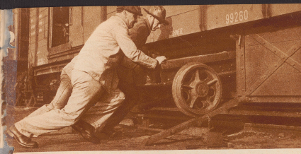
Im Führerstand des Hilfswagens wird ein kompletter Rollwagen mitgeführt, der auf unklipplichen Schienen herangebracht werden kann.
