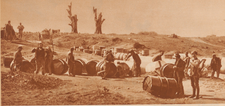
Montenegrinisches Stangenart in ersten Balkankrieg. Leere eiserne Benzinfässer wurden mit einem Holzgerüst ausgekleidet, das ringsum einen Spalt von 10 cm abließ, der dann ausbestrichen wurde. Bei der Belagerung von Skutari im November brach Angriff der Stadt von der See-Seite aus, wodurch die Fässer von je drei Mann vor sich hergeführt und hinten so einem guten Kapselung, der auch das belagerte feindliche Infanteriefeuer wärmeisoliert machte.
